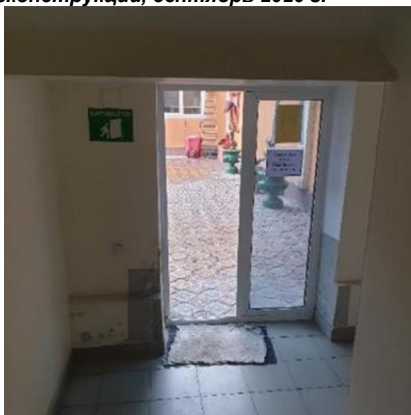
Фото 7: Вход в офис ГУП до реконструкции, сентябрь 2020 г.
