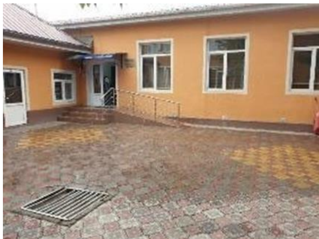
Фото 5: Внутренний двор офиса ГУП до реконструкции, сентябрь 2020 г.
