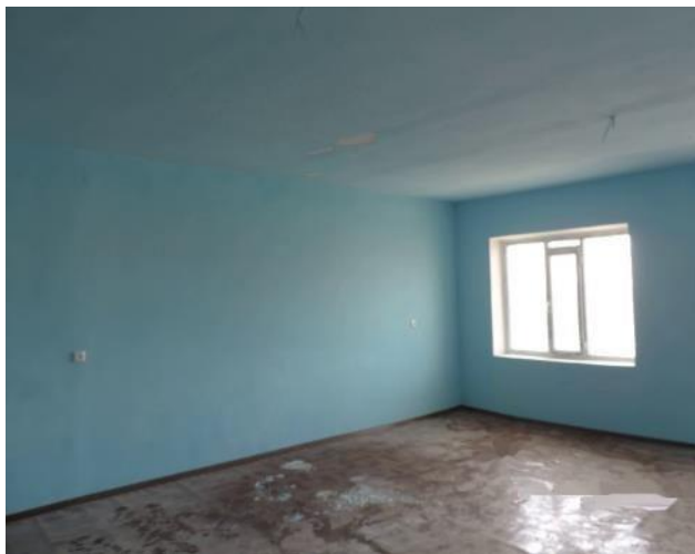
Фото 11: Офис ГУП в МОЛМЕ до реконструкции, сентябрь 2020 г.
