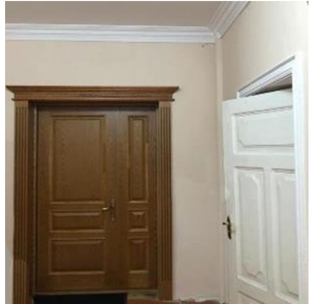
Фото 14: Дверь в офис ГУП в МОЛМЕ после восстановления, сентябрь 2021 г.
